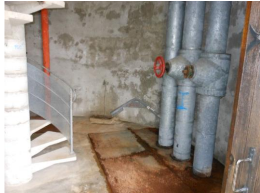
Distribution de l'eau dans le château d'eau, vers le réservoir ou du réservoir vers les consommateurs.
