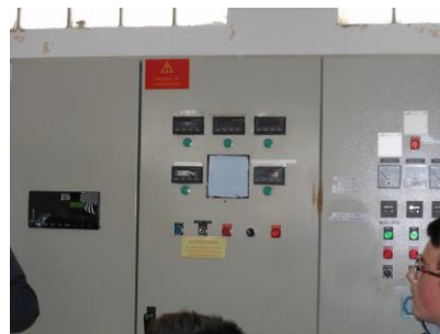
Compteurs d'eau des communes à Poncey
