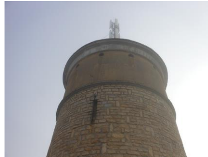
Réservoir du château d'eau en haut
