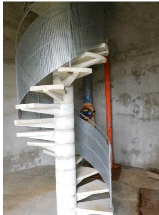
Escalier à l'intérieur qui monte vers le réservoir
